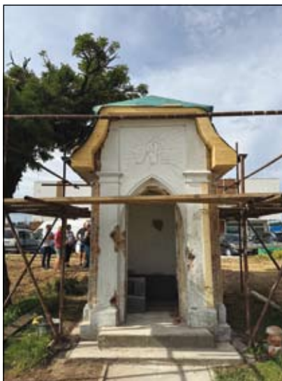
přední pohled na rekonstrukci kapličky
