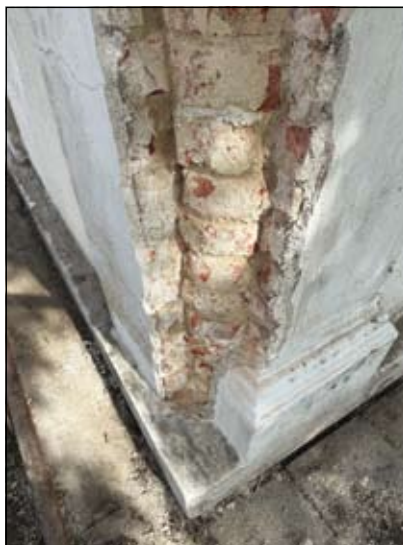
detail zdi – původní rohy nebyly do hrany, ale zaoblené
