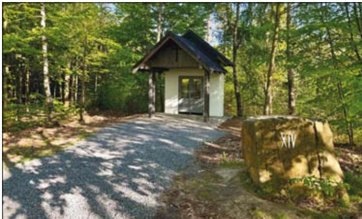
Kaplička na XIV. zastavení křížové cesty, stavbu realizovala firma MV STABY Vjačka, s.r.o.
