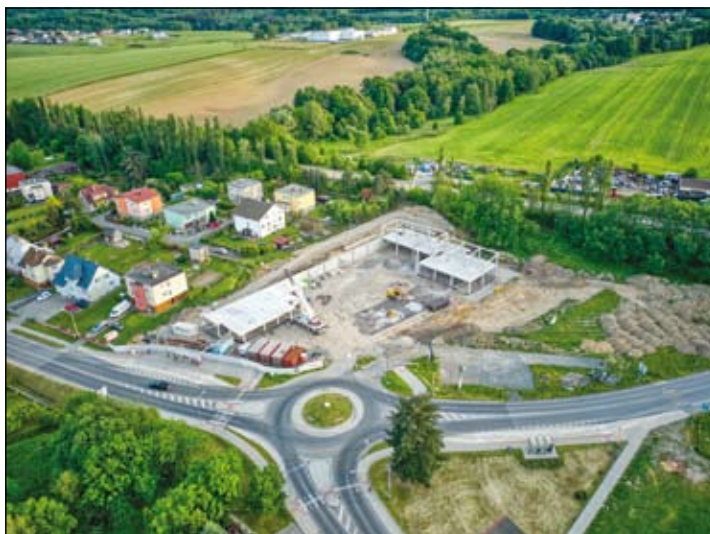
pohled na kruhový objezd a stavbu Centra služeb a obchodu Hruška
