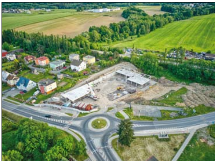
pohled na stavbu Centra služeb a obchodu Hruška
