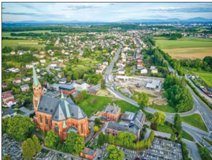
pohled na kostel sv. Mikuláše a stavbu Centra služeb a obchodu Hruška
