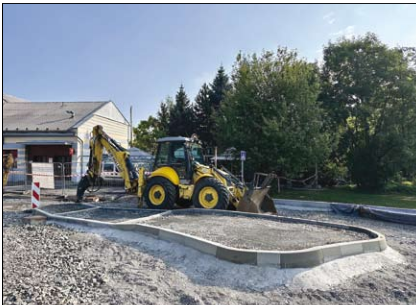
stavba kruhového objezdu – stav k 22. srpnu 2023
