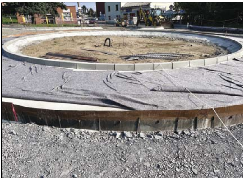
stavba kruhového objezdu – stav k 22. srpnu 2023
