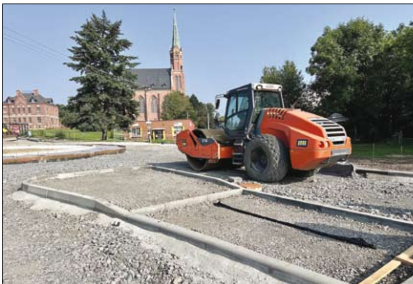
stavba kruhového objezdu – stav k 22. srpnu 2023
