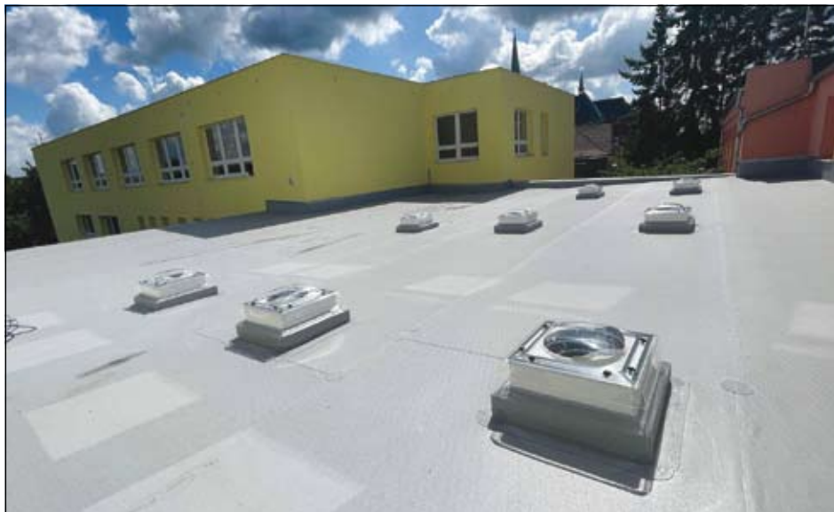
střecha se světlovody
