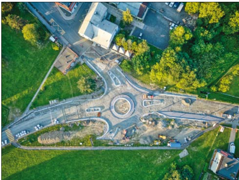
stavba kruhového objezdu 20. srpna 2023 kolem 18:30 hod.
