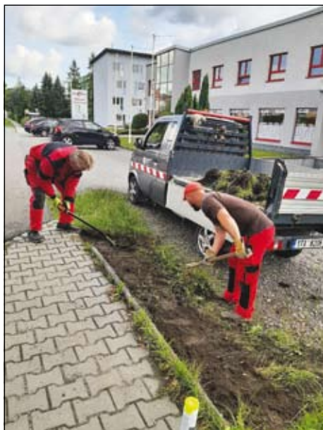
příprava na zhotovení betonových základů
