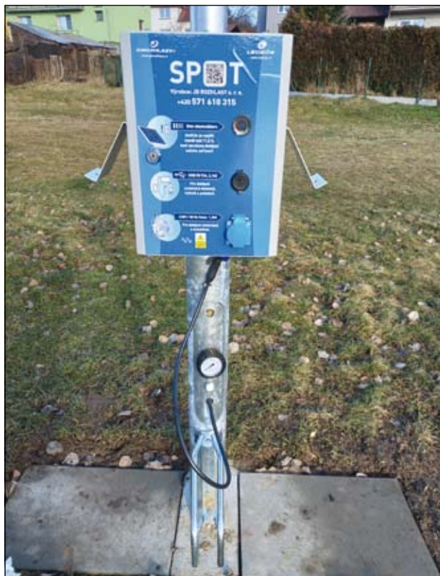
nabíjecí stanice pro elektrokola
