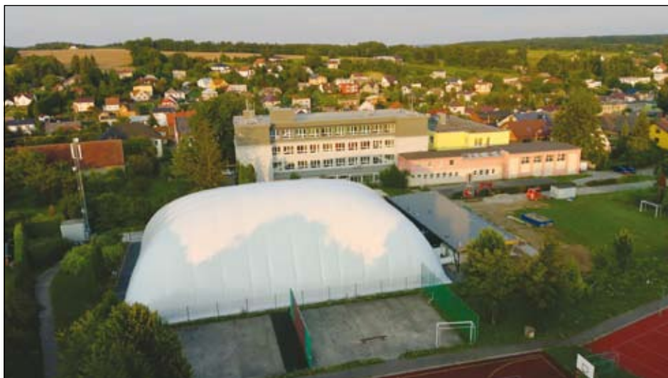
nafukovací hala, zadní část ZŠ
