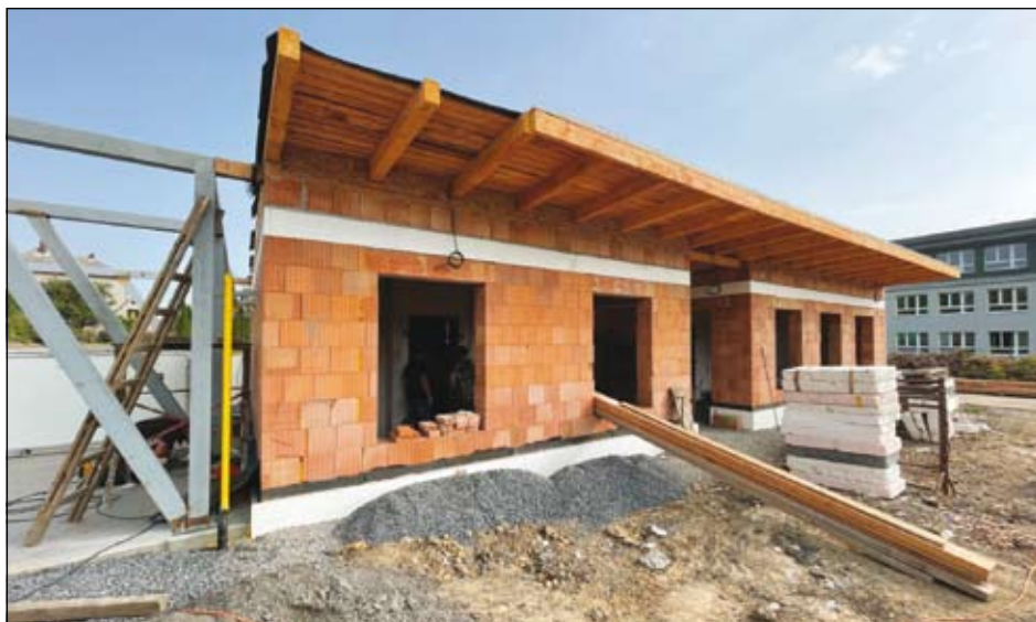
výstavba sociálního zázemí pro nafukovací halu
