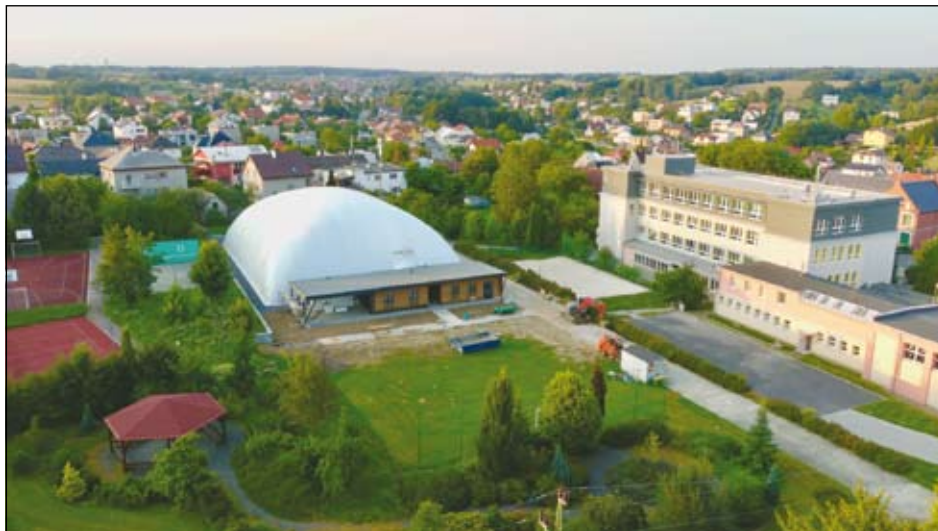
nafukovací hala se sociálním zázemím, zadní část ZŠ
