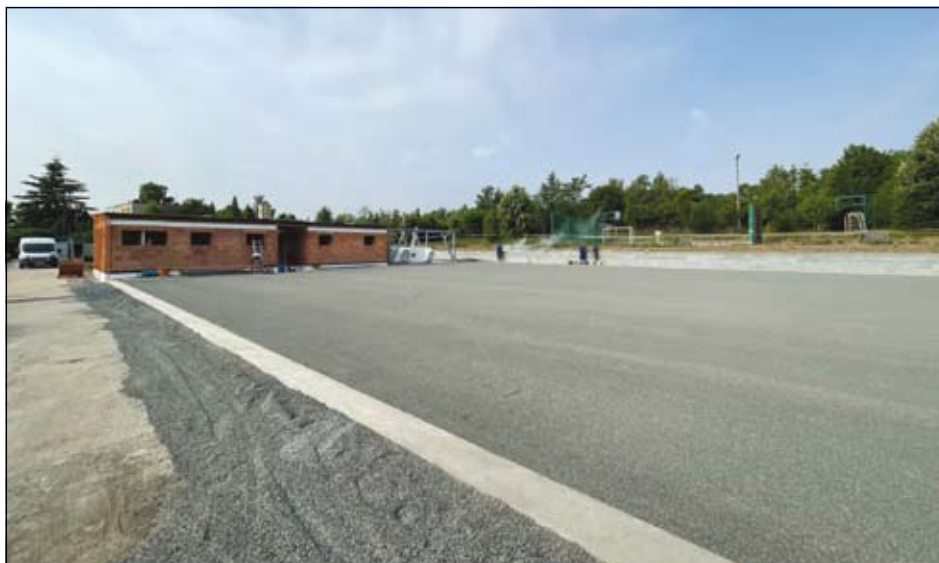
prostranství pro stavbu nafukovací haly, v pozadí výstavba sociálního zázemí
