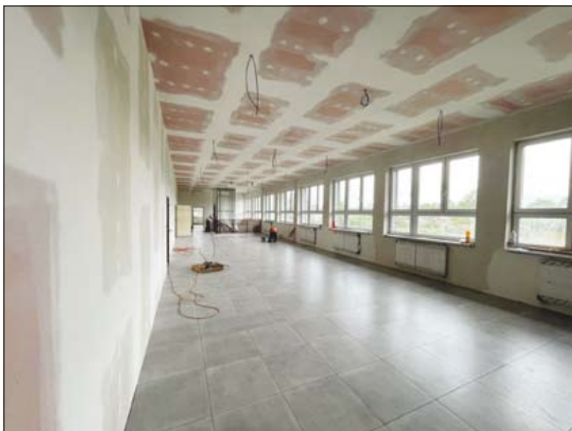
dláždění chodeb, stropy a stěny před výmalbou – květen 2021
