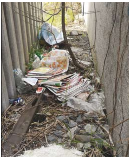
odpadky pod mostem – ul. Lípová
