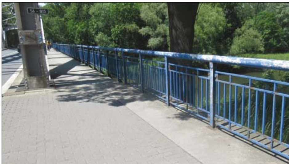
most na silnici I/56 v Ostravě
