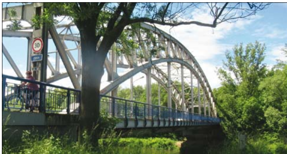
konstrukce mostu na silnici I/56 v Ostravě
