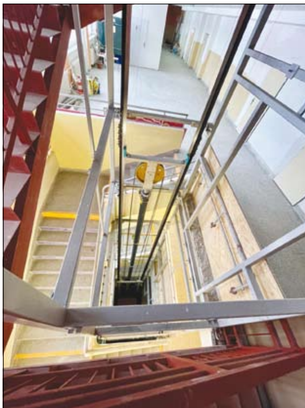
pohled do výtahové šachty – 19. ledna 2021
