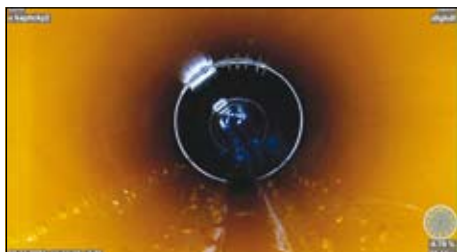
pohled do potrubí po úspěšné instalaci spon, před zacvaknutím chráničky
