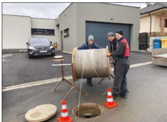
odvítěn chráničky z bubny a její instalace
