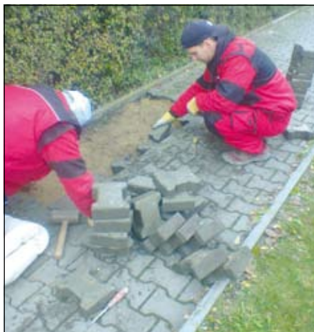
oprava dlažby chodníku
