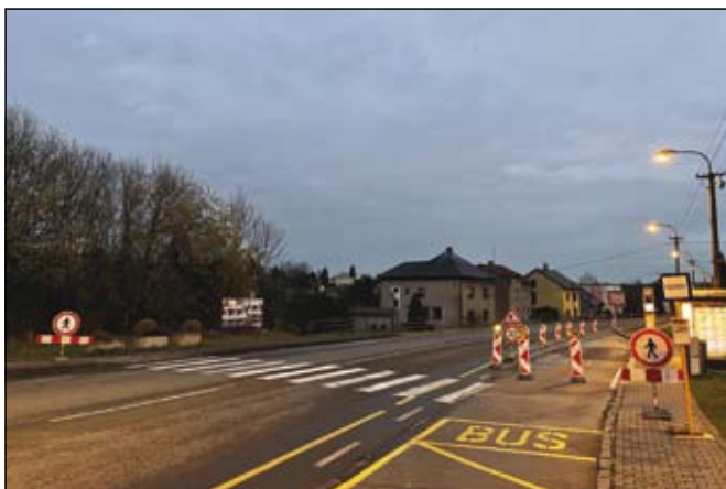
rekonstrukce autobusové zastávky
