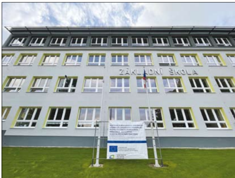
budova základní školy
