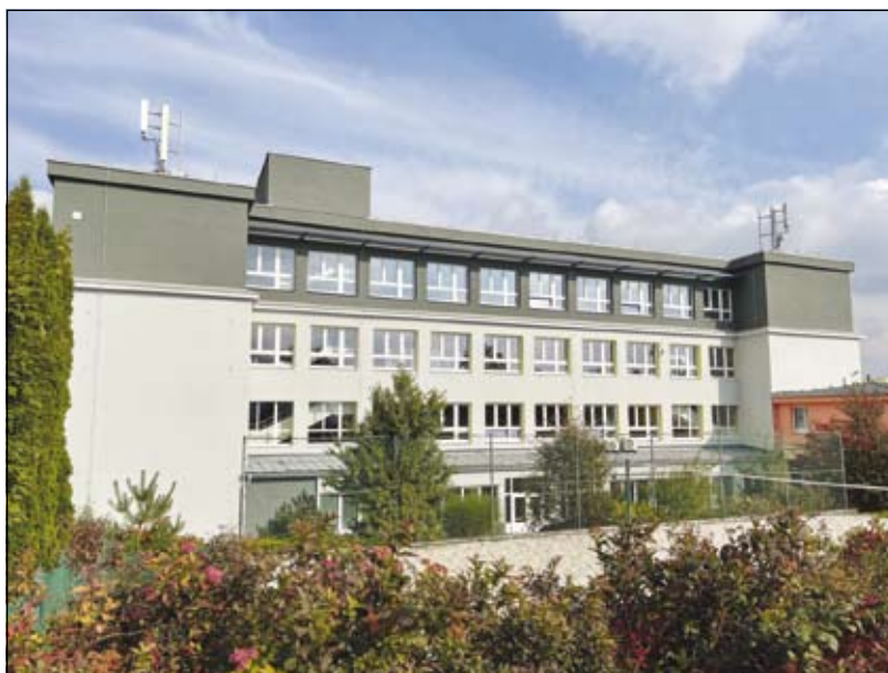
budova základní školy
