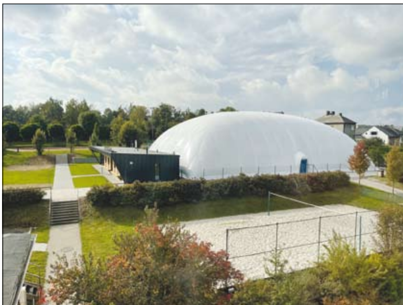
nafukovací hala a sociální zázemí
