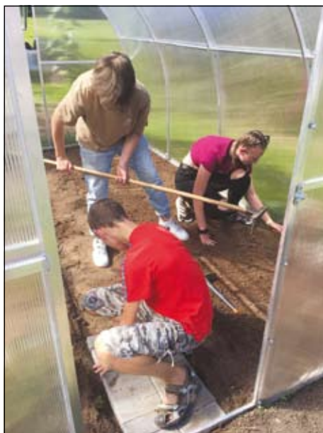
žáci 9. B upravují vnitřek nového skleníku
