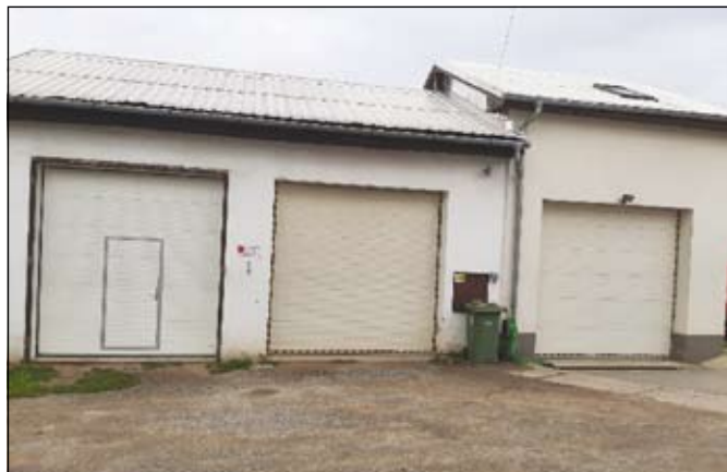
garáže pod poštou
