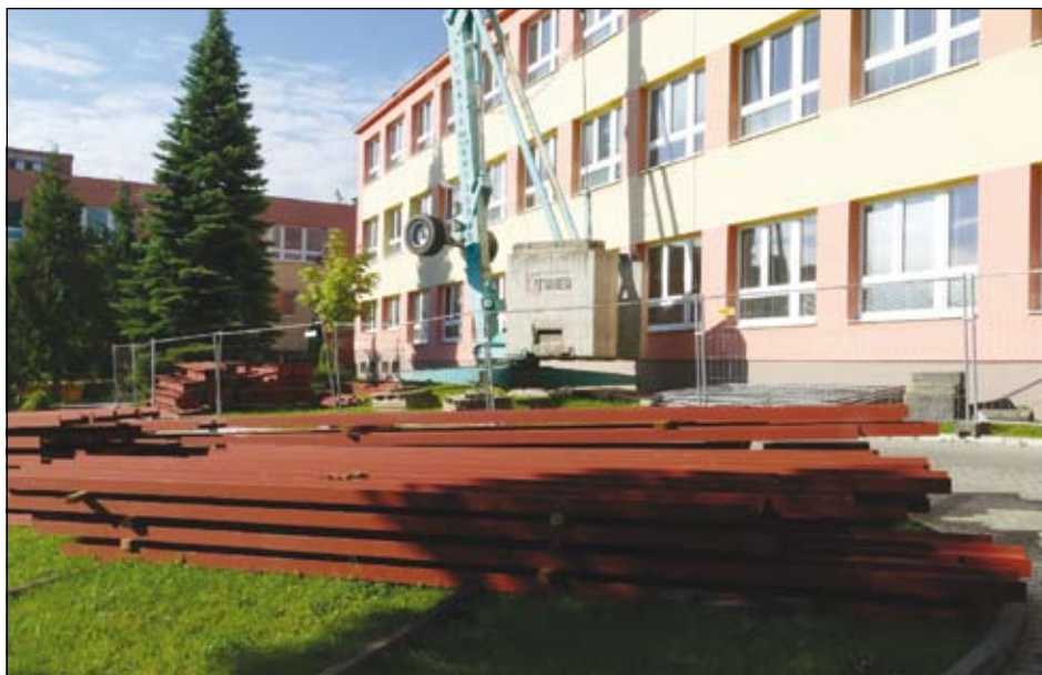
materiál na nástavbu základní školy
