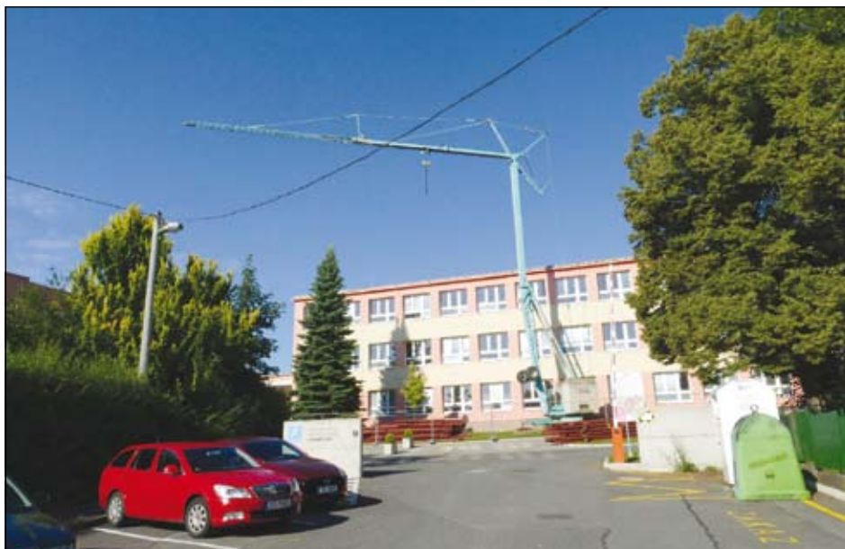
stavební jeřáb – nástavba základní školy
