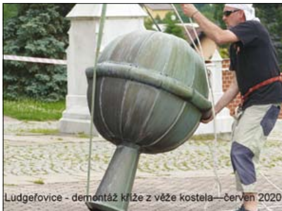
Ludgerovice - demontáž kříže z věže kostela—červen 2020
