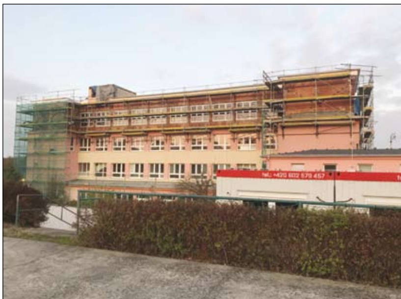
nástavba školy – pohled od školního hřiště
