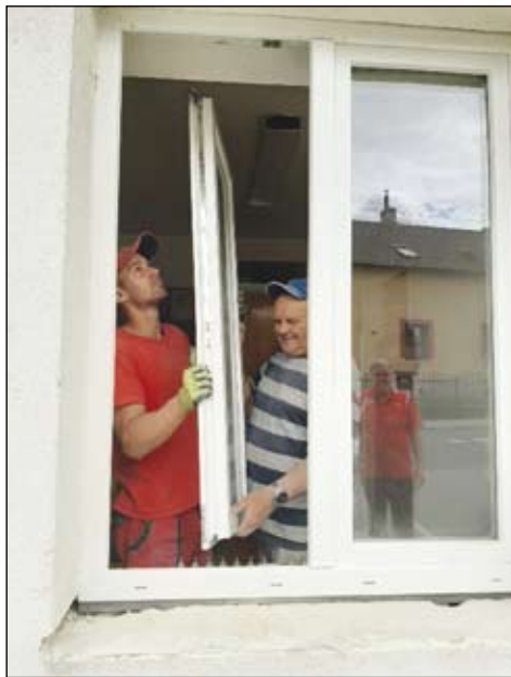
výměna oken na poště
