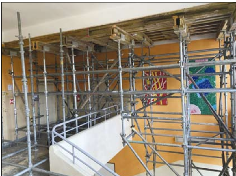
nástavba školy – vnitřní prostory
