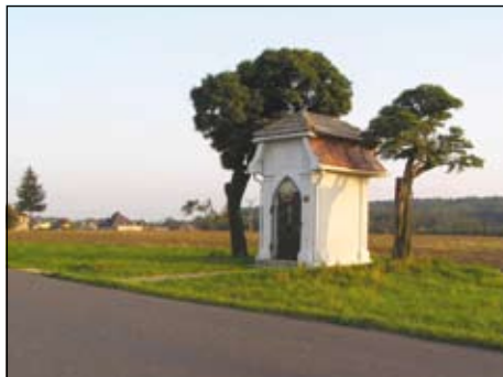
Panská kaple „na staré cestě“
