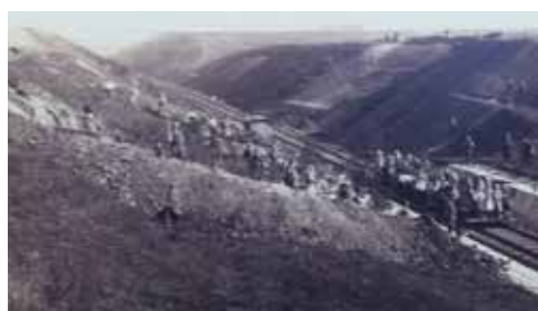
Výstavba železniční tratě Hlučín – Petřkovice (po roce 1920)
