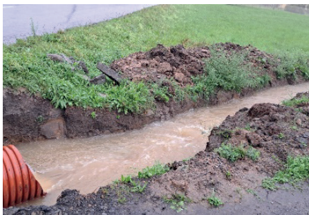
Velkým přínosem jsou nové propustky pod silnicí III. tř.
