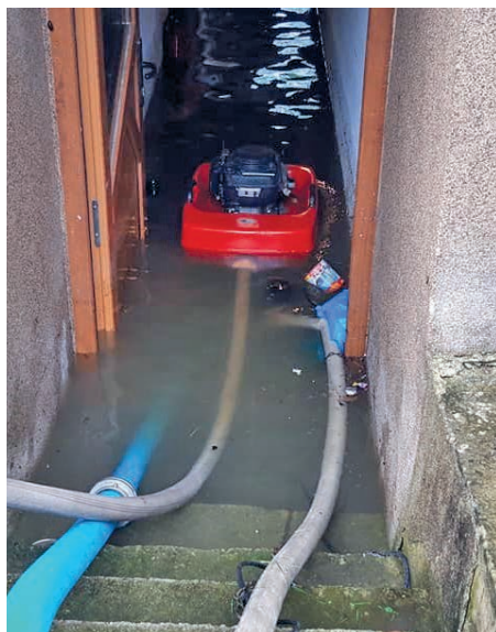
Nasazení čerpadel u zadního vchodu bytovky
