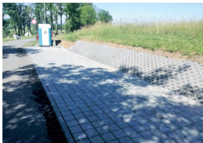
Oprava komunikace ulice Vyhliďková.
