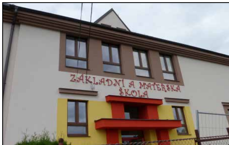
Základní škola a Mateřská škola v Hradišti po dokončené rekonstrukci
