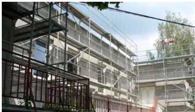
Rekonstrukce kulturního domu v Hradišti
