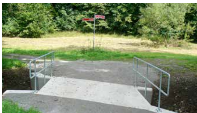
Mostek po generální opravě - ul. Hasičská
