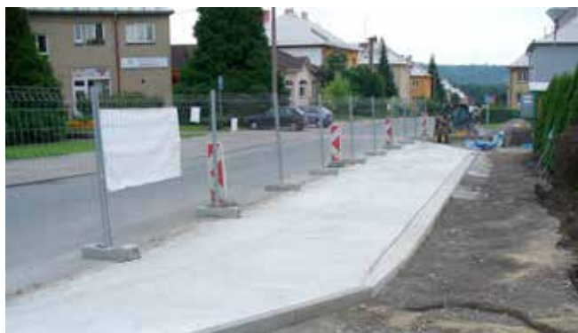
Oprava autobusové zastávky na náměstí
