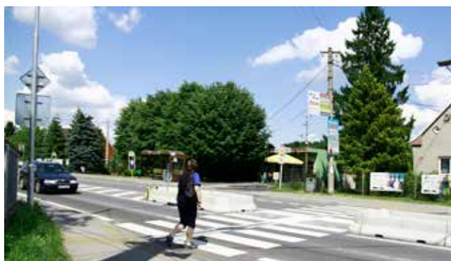
Nové bezpečné přechody na ulici Těšínské
