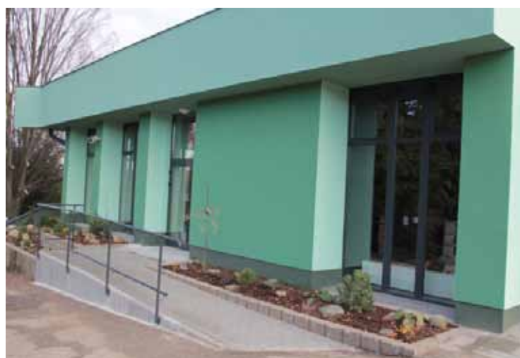
Nový bezbariérový vstup do smuteční síně
