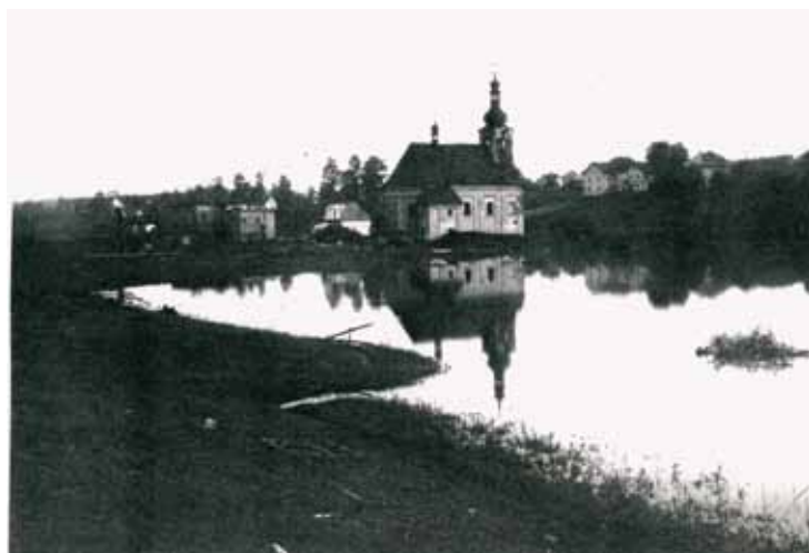
Kostel a okolí těsně před demolicí.
