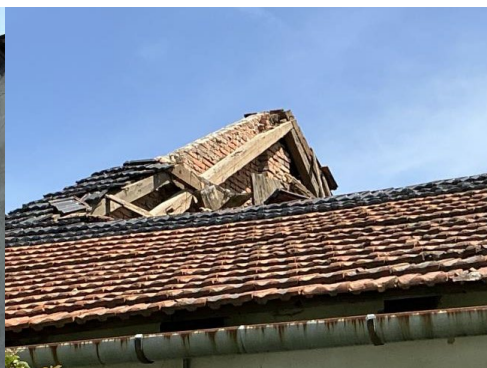
Štít se zbytky konstrukce krovu
