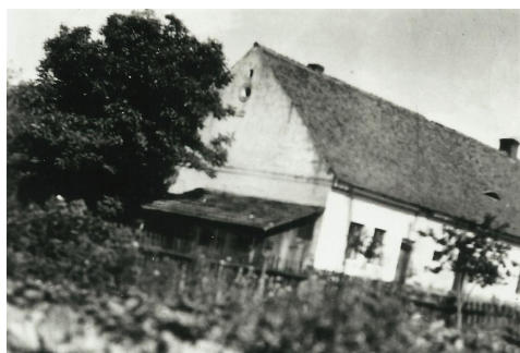
Rodný dům Aleny Poláškové, Libhošť č. p. 51. Stavení dnes nikdo neobývá.
