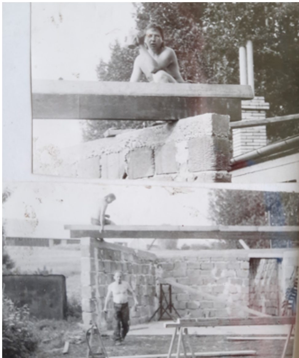
Fotografie z výstavby šaten (Jan Polášek) a dole z výstavby vedlejší budovy a skladiště.
