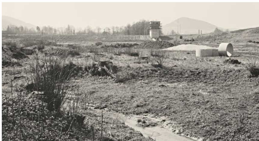
Výstavba přehrady – pohled směr Kopřivnice. Foto: Rudolf Jarnot.
