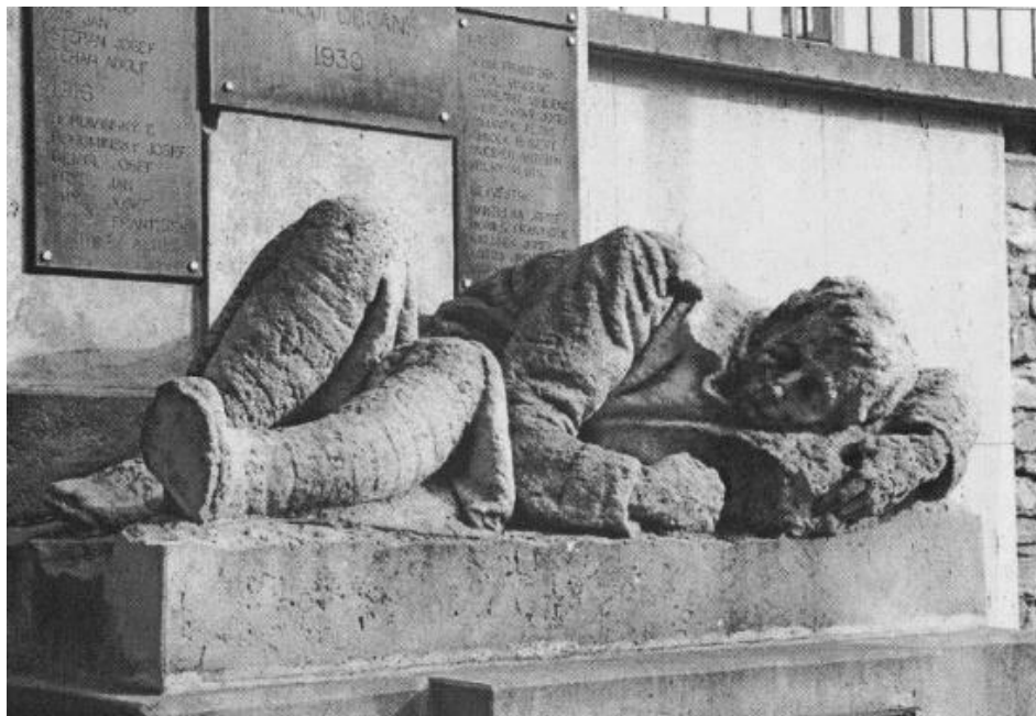
Stav památníku po neodborném zásahu při odstraňování mechu a nazelenalého „porostu“ otryskáním. Poškození sochy bylo značné.
