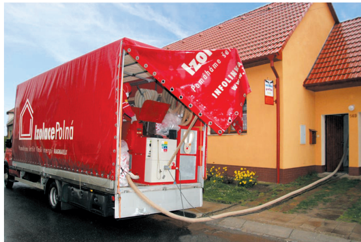
Foukání izolace hadicí z vozu před domem
