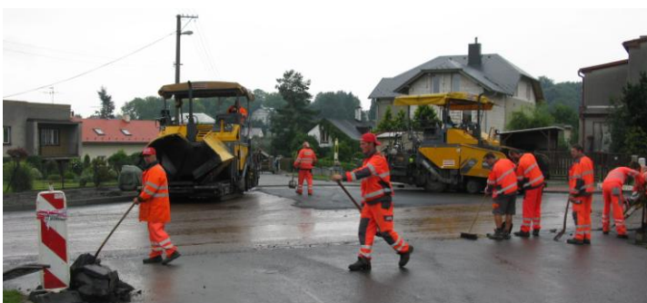
Oprava křižovatky u lípy
