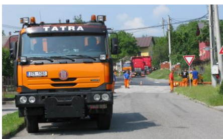
Oprava křižovatky u školy
