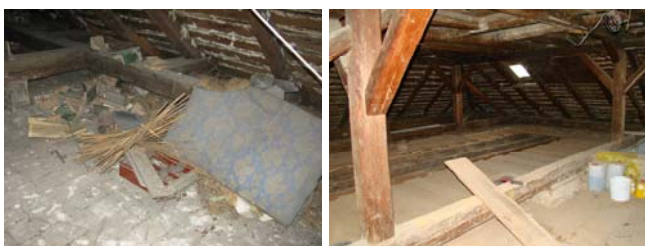
Před zahájením prací
