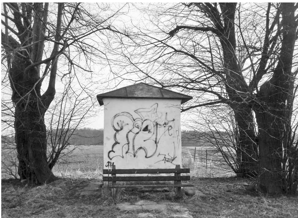
Kaplička před opravou
