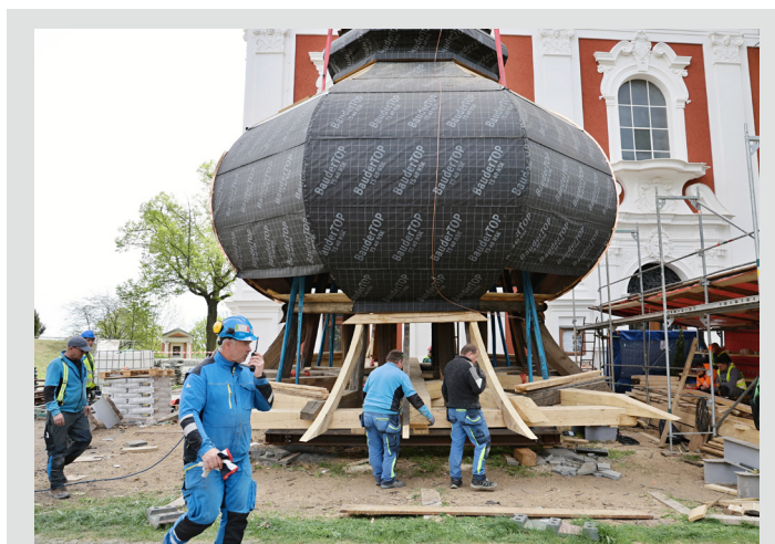
Po mnoha hodinách příprav v pondělí 4. května po poledni speciální jeřáb na věž cvilinského kostela vyzvedl opravovanou baň. Ta váží 18 tun a po usazení ji nyní čeká dopláštění, které by mělo být hotovo nejpozději do konce května.
