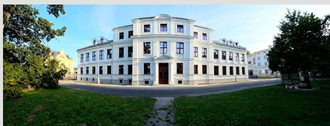
V loňském ročníku byla jednou z oceněných staveb také budova ZUŠ Krnov.
