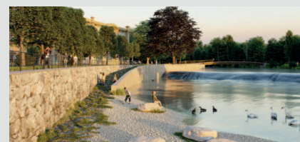
V podjezdu vzniká pobytové místo zpřístupněné rampou.
