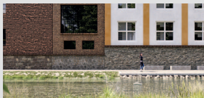
V části náplavky jsou sanovány stávající kamenné sokly.
