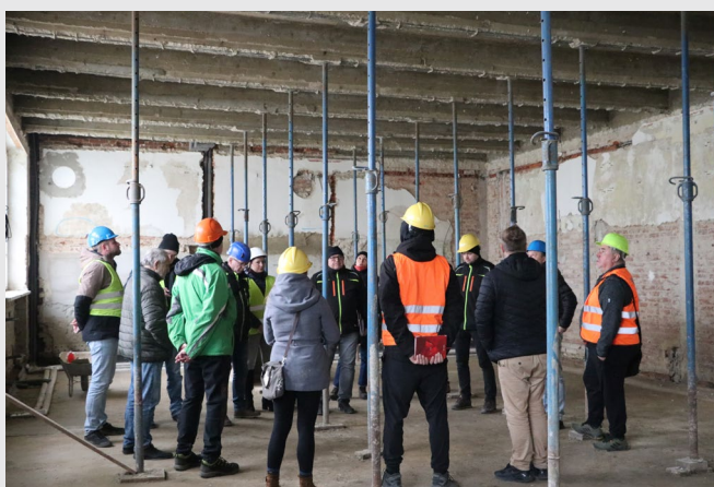
O způsobu řešení opravy narušené statiky stropní konstrukce nad malou tělocvičnou rozhodovalo množství odborníků. Foto: Dita Čírová
