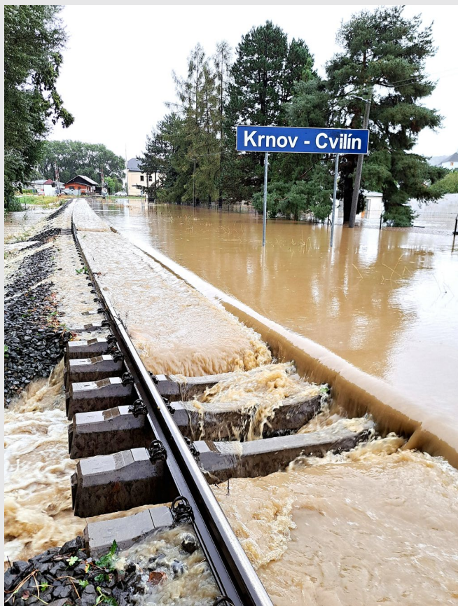
V neděli dopoledne už voda přetékala také přes koleje u cvilínského nádraží.
