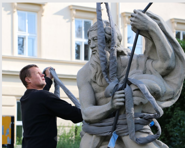
Kašna u Švédské zdi je v rekonstrukci. Aby během oprav vany, technologie a vodoinstalace nedošlo k poškození sochy Neptuna, byla plastika v úterý 8. srpna demontována a převezena na bezpečné místo.
