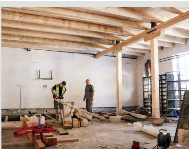
Ve vyhořelé dezignatuře je už mimo jiné opraven strop a v části, kde býval sklad vzorníků, v němž v roce 2017 vypukl požár, vzniká nová podlaha.
