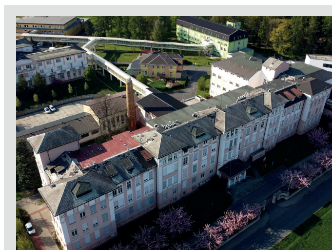
Střecha historické budovy nemocnice v Krnově patří svojí rozlohou mezi největší v regionu.
