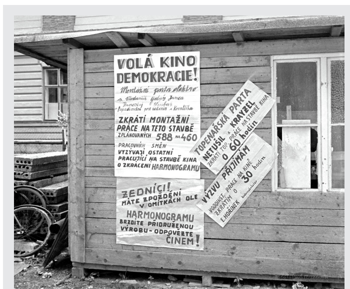
Snímek z roku 1958 zachycuje stavební boudu v době rekonstrukce kina.
