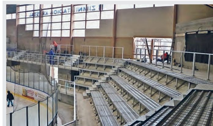
Na zimním stadionu pokračuje výstavba severní tribuny. Stupně jsou připraveny na betonáž, pracovníci budují požární schodiště, v „podpalubí“ se už rýsují šatny, sociální zařízení, kanceláře i malá tělocvična. Dokončení stavby za 42 milionů korun je plánováno na druhou polovinu dubna.
