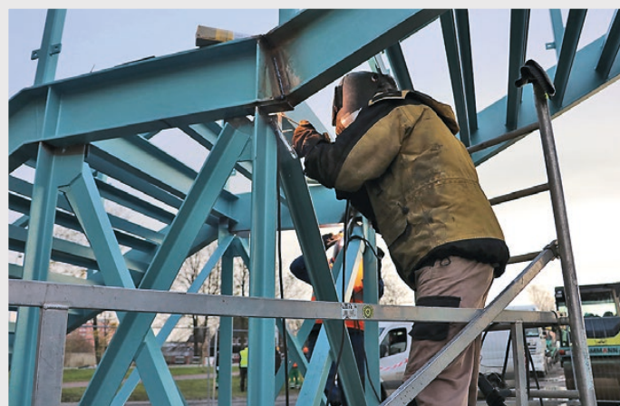
Oprava lávky u hlavního nádraží finišuje. Po osazení schodišť a výměně pochůzní plochy na mostovce zbývají už jen dokončovací práce a získání kolaudačního rozhodnutí. Rekonstrukce lávky stála 6,6 milionu korun.
