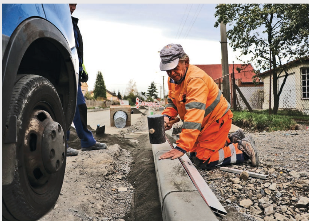
Po ukončení první etapy opravy bude mít komunikace v Chářovské ulici rovný povrch, na němž bude položena první vrstva asfaltu, dokončeny budou chodníky i obruby po obou stranách cesty. Foto: Tomáš Gaudek
