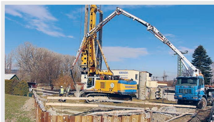
U vodárny Zlatá Opavice se buduje estakáda, která přemostí cyklostezku a řeku. Foto: Dita Círová
