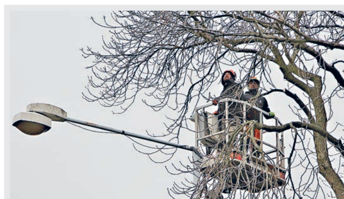
V zahradě městské knihovny ve středu 13. února odborníci na ošetřování stromů prováděli ořez dvou jírovců, a to z důvodu provozní bezpečnosti. Foto: Tomáš Gaudek
