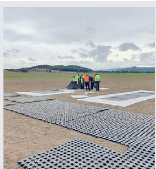
Výstavba nové vzletové dráhy na letišti se chýlí ke konci. Foto: archiv Aeroklubu Krnov
