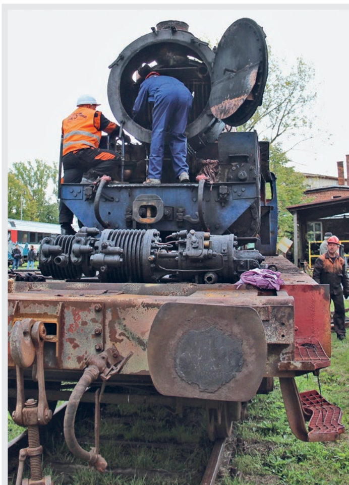
Ve čtvrtek 10. října byl kotel z lokomotivy vyndán a převezen k opravě do Kolína. Foto: Tomáš Gaudek
