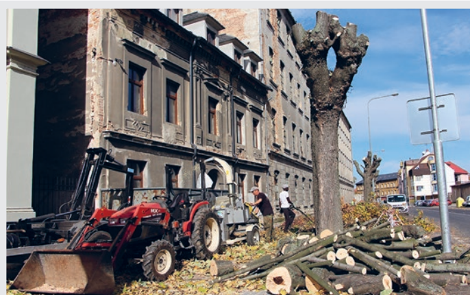
V Soukenické ulici minulý týden začala obnova zeleně. Po kácení dřevin bude následovat výsadba stromů i keřů a regenerace trávníků. Regenerace zeleně navazuje na letošní opravu komunikace, jejíž součástí byla rekonstrukce a modernizace zastávek MHD, vybudování parkovacích míst i nového přechodu pro chodce. Foto: Dita Círová
