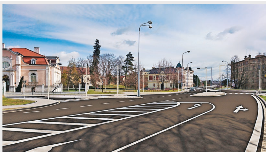
Současná průsečná křižovatka bude nahrazena dvěma odsazenými křižovatkami. Na frekventovaném Říčním okruhu se tím sníží počet jízdních pruhů i přechodů pro chodce. Vizualizace: Bontevia, s. r. o.
